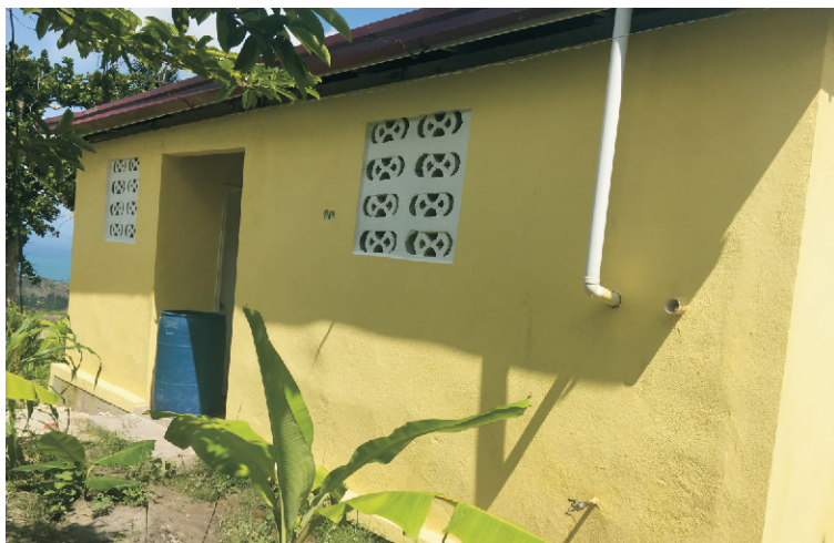
Vue de l'arrière-cour d'un des logements.
